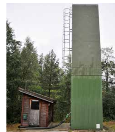
Kalking mot sur nedbør har vært en stor suksess på Sørlandet. Denne kalk- doseren står i Uldalsgreina i Tovdalsvass- draget.
